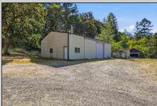
Spacious Shop & Bay Door
