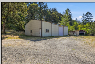
Spacious Shop & Bay Door
